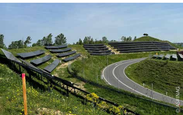
PV Raststation Schwechat
